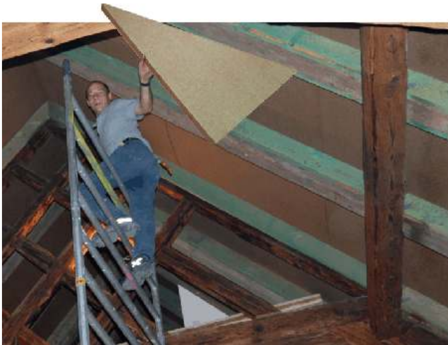
Zwischensparrendämmung mit Hofatex® Therm DK
