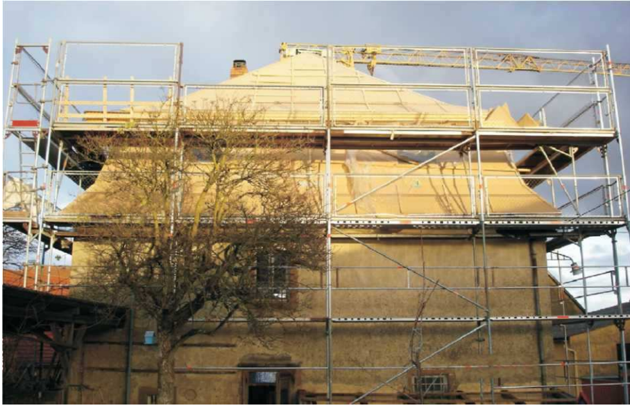
Isolation extérieure des murs avec Hofatex®
